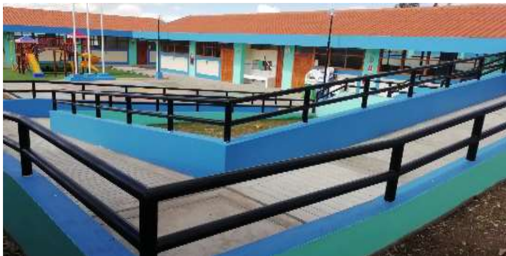
INFRAESTRUCTURA EDUCATIVA DE LA I.E DEL NIVEL INICIAL N° 555 SAN MIGUEL DE PÚACCOCHA, DEL DISTRITO DE ACORIA, PROVINCIA DE HUANCVELICA
